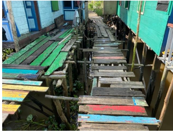
Gambar 3.5 Kondisi Jalan di Pulau Kemaro
