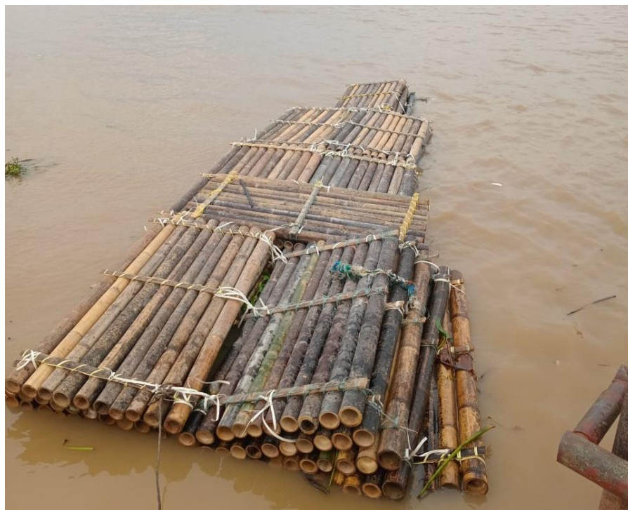
Gambar 3.44 Perbaikan Rakit Floating Farming
