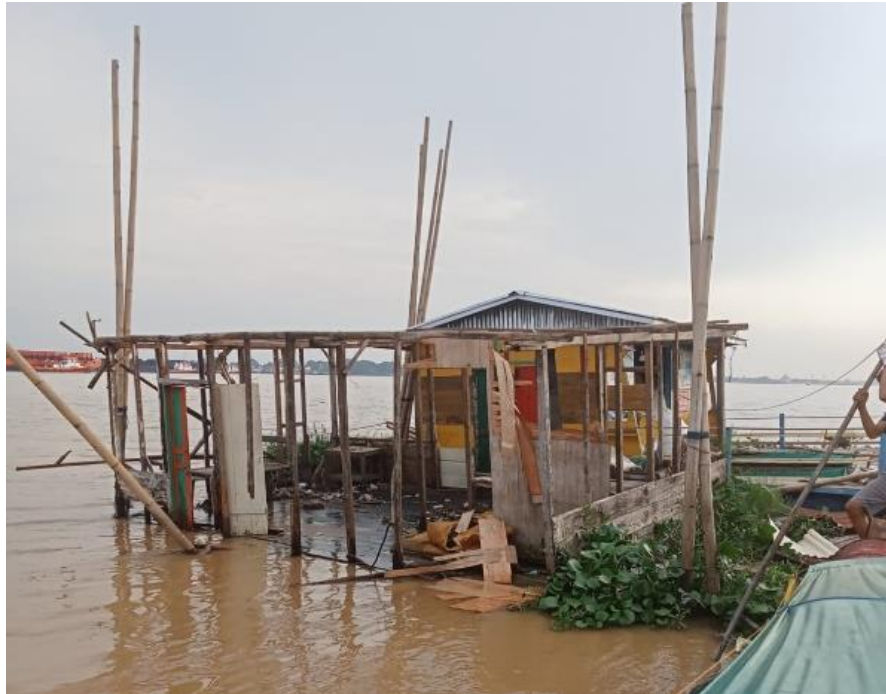
Gambar 3.46 Renovasi Tabungan NONA
